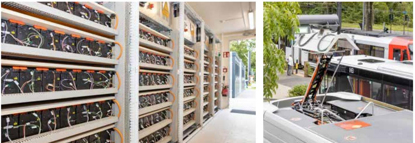
Die dazu nötige Ladeinfrastruktur steht an der KVB-Haltestelle „Bocklemünd“. Sie besteht aus einer Ladestation, einem Lademast für E-Busse und zwei Ladesäulen mit jeweils zwei Schnellladepunkten für Elektrofahrzeuge. Die Ladestation selbst unterteilt sich in einen Batterie- und einen Schaltraum. Die Ladesäulen für Elektrofahrzeuge befinden sich im Erdgeschoss der benachbarten P&R-Anlage.
