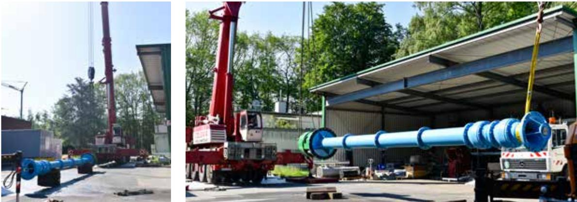
In Weiler musste auch eine sogenannte Rohrwellenpumpe mit einer Länge von elf Metern generalüberholt werden. Sie ist ein wahrliches Schwergewicht, denn sie kann in einer Stunde rund 2.000 Kubikmeter Wasser verteilen. Seit ihrer letzten Überholung ist sie mehr als 50.000 Stunden gelaufen. Das entspricht fast sechs Jahren. Nach den Revisionsarbeiten ist sie für die nächsten 50.000 Stunden betriebsbereit.
