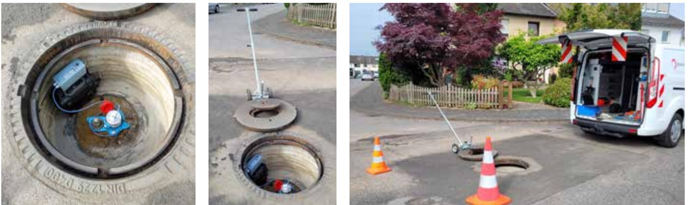
Im Verdachtsfall Rohrbruch prüft unser mobiler Entstördienst die Situation vor Ort und leitet, wenn nötig, eine Reparatur ein. Auf diese Weise versuchen wir kleinste Schäden frühzeitig zu erkennen und zu beheben, bevor Rohre in großem Ausmaß repariert oder ausgetauscht und unterspülte Straßen saniert werden müssen. So reduzieren wir den Materialeinsatz und schonen Ressourcen. Auch die Auswirkungen auf Verkehr und Umwelt bleiben gering.
