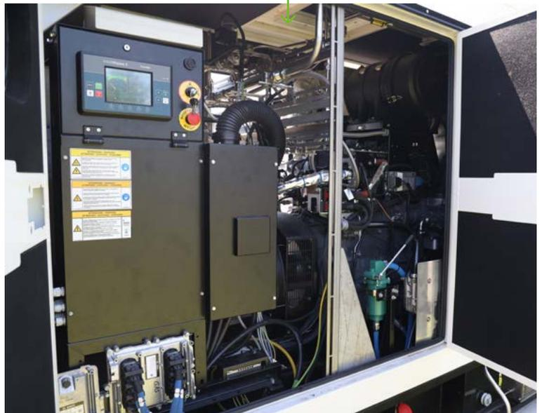
Die Kombination aus einem Wasserstoffmotor und einem Generator liefert in der ersten, sechsmonatigen Testphase bis zu 170 Kilovoltampere (kVA) elektrische Leistung. Der so erzeugte Strom wird direkt in das Kölner Stromnetz eingespeist. In einem zweiten Schritt wollen wir auch die Abwärme aus dem Aggregat zur Wärmeerzeugung nutzen. Der Pilotversuch bietet großes Potenzial für eine dezentrale und CO<sub>2</sub>-neutrale Energieversorgung in Ballungsräumen wie Köln.
