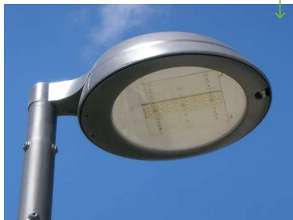
Im Rahmen eines Pilotprojekts im Neubaugebiet Widdersdorf-Süd wird erstmals LED-Technik zur Beleuchtung öffentlicher Straßen installiert. Inzwischen ist die Technik – die gegenüber herkömmlichen Leuchten bis zu 75 Prozent weniger Energie verbraucht und weniger Streulicht erzeugt – etabliert und wird an vielen Orten eingesetzt.
