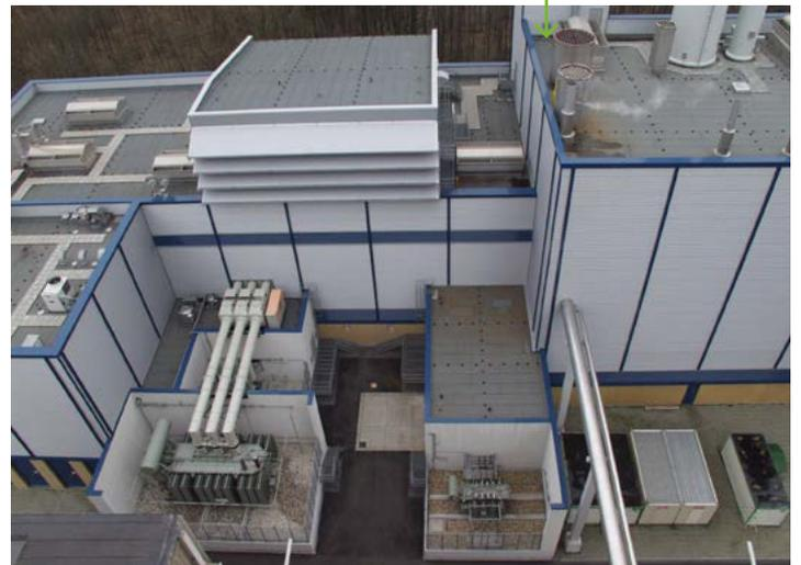
Neben dem Heizkraftwerk Merkenich wird eine Gas- und Dampf-turbinen-Anlage errichtet. 2010 wurden zwei Dampfturbinen ausgetauscht, um die Energieeffizienz zu steigern.
