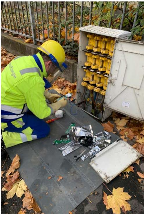
Wir haben uns zum Ziel gesetzt, die Stromnetze in der Nieder- und Mittelspannungsebene zu digitalisieren. Durch eine Vielzahl von Sensoren im Stromnetz erwartet unser Unternehmen eine bessere Ausnutzung der bestehenden Infrastruktur und will damit einen Mehrwert für die Menschen schaffen. Die Sensoren überwachen die Temperatur und Feuchtigkeit des Innenraums und der Stromkabel in unseren Verteilerschränken sowie die Tür des Stromverteilerkastens und erfassen mögliche Erschütterungen.
